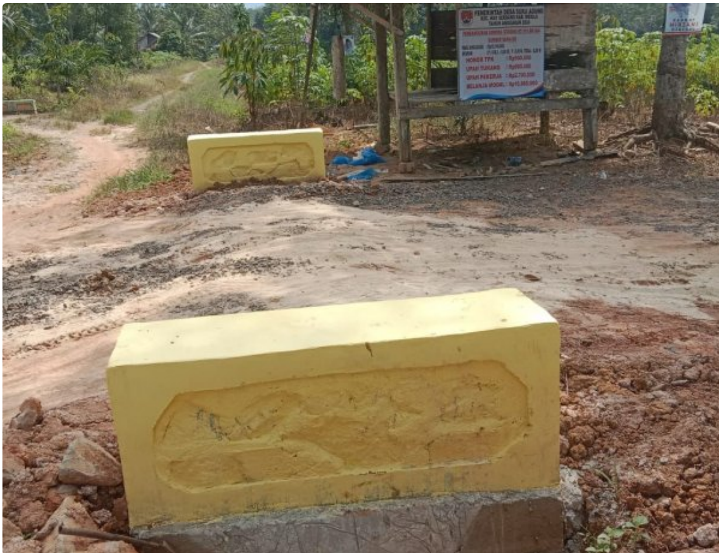
Pembangunan gorong-gorong Desa Suka Agung
